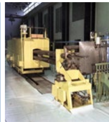
Установка удаления влаги из негерметизированного ТВЭЛ в цехе № 4
