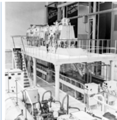
Установка наклонного снаряжения ТВЭЛ в цехе № 4
